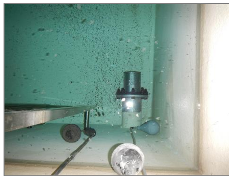
Bête avec crépine et poires de niveau
