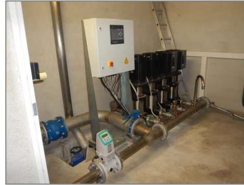
Intérieur du local
