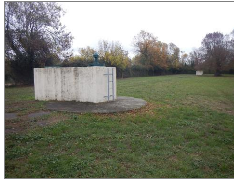
Tête du forage (F4 et F5 à l'arrière)
