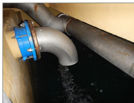
Adduction et conduite d'aération
