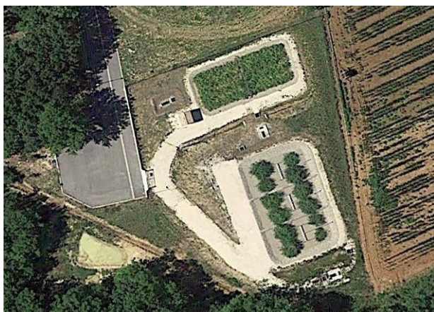
Aperçu général du site (vue aérienne)
