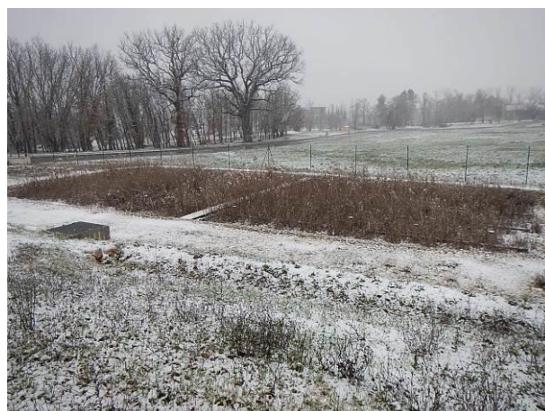
Filtres plantés de roseaux (2 ème étage)
