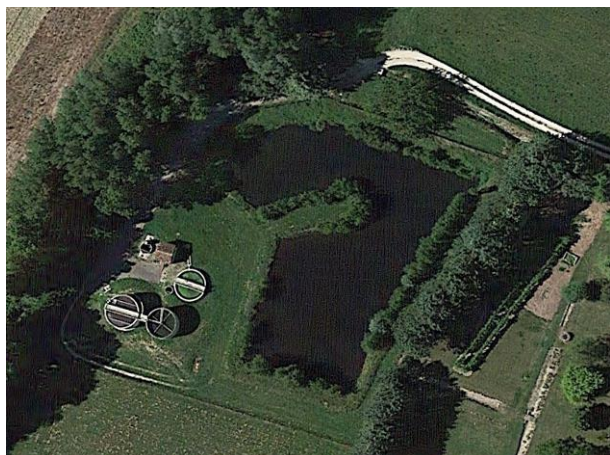
Aperçu général du site (vue aérienne)
