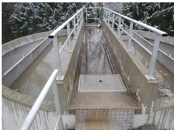
Décanteur-digester
