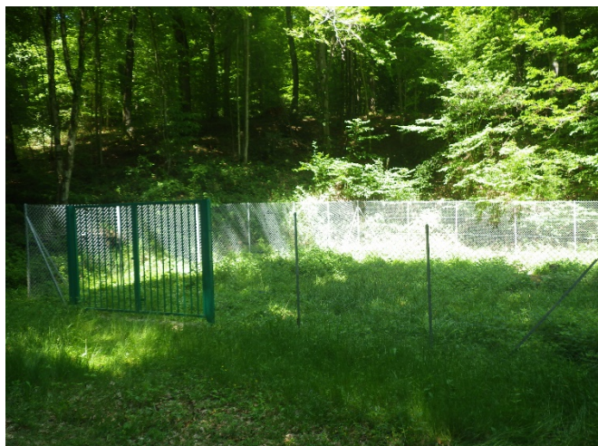
Captage du Magny (Beaumont)
