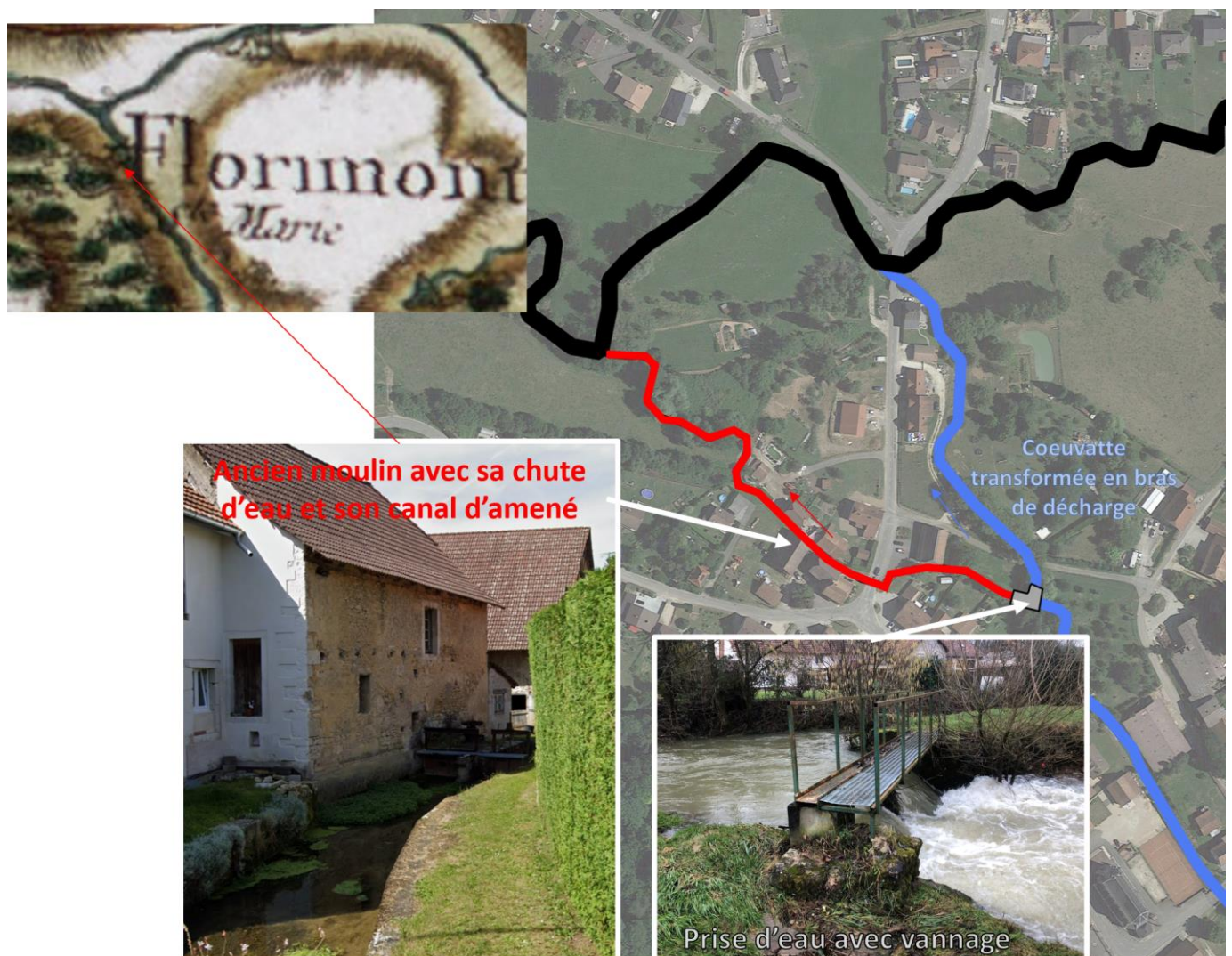
Figure 10 : Position du canal d'amené, de la chute et de la prise d'eau liés au moulin de Florimont depuis au moins le 18 e siècle
