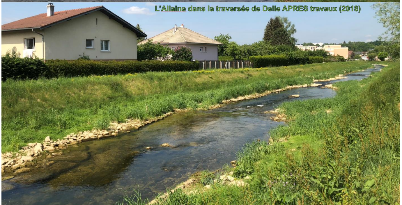
Figure 16 : photographies montrant les travaux de réhabilitation réalisés dans la traversée de Delle. Les éléments minéraux de grandes tailles structurent le lit en basses eaux et redynamisent les écoulements.
